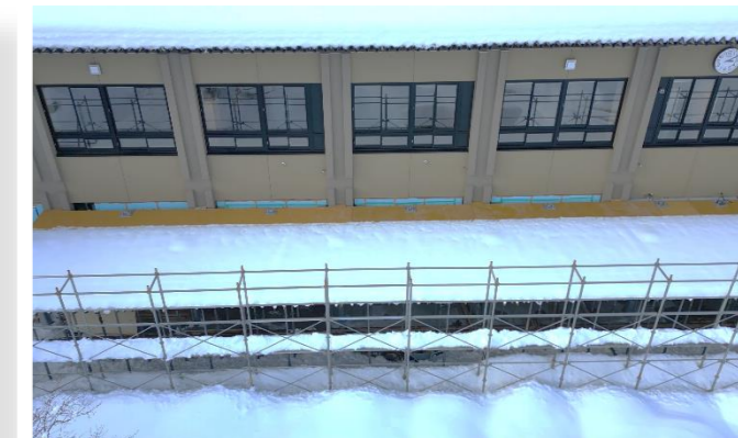
校舎側「荘川のこみち」建設中
